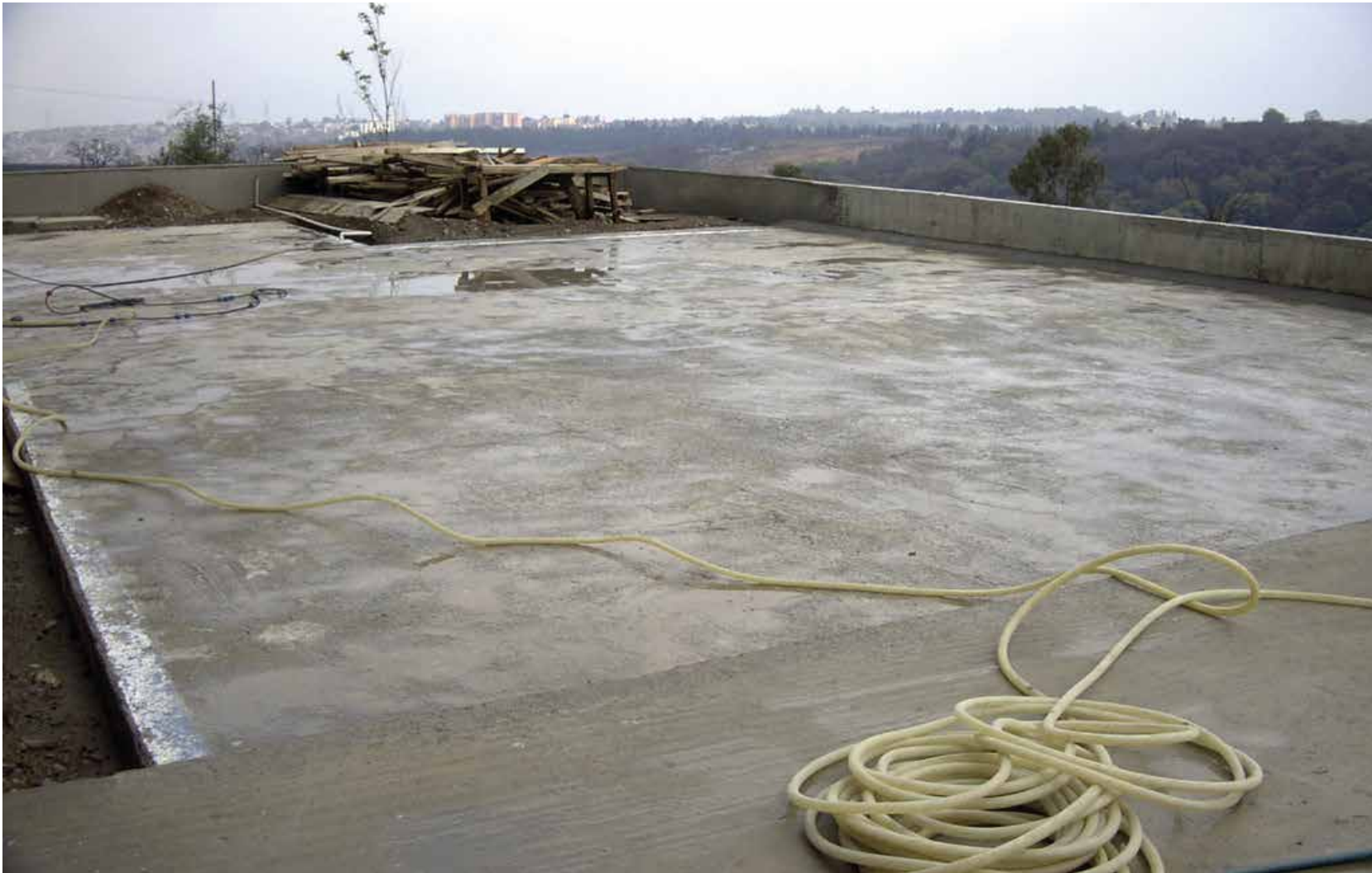
Estado original de la losa.
