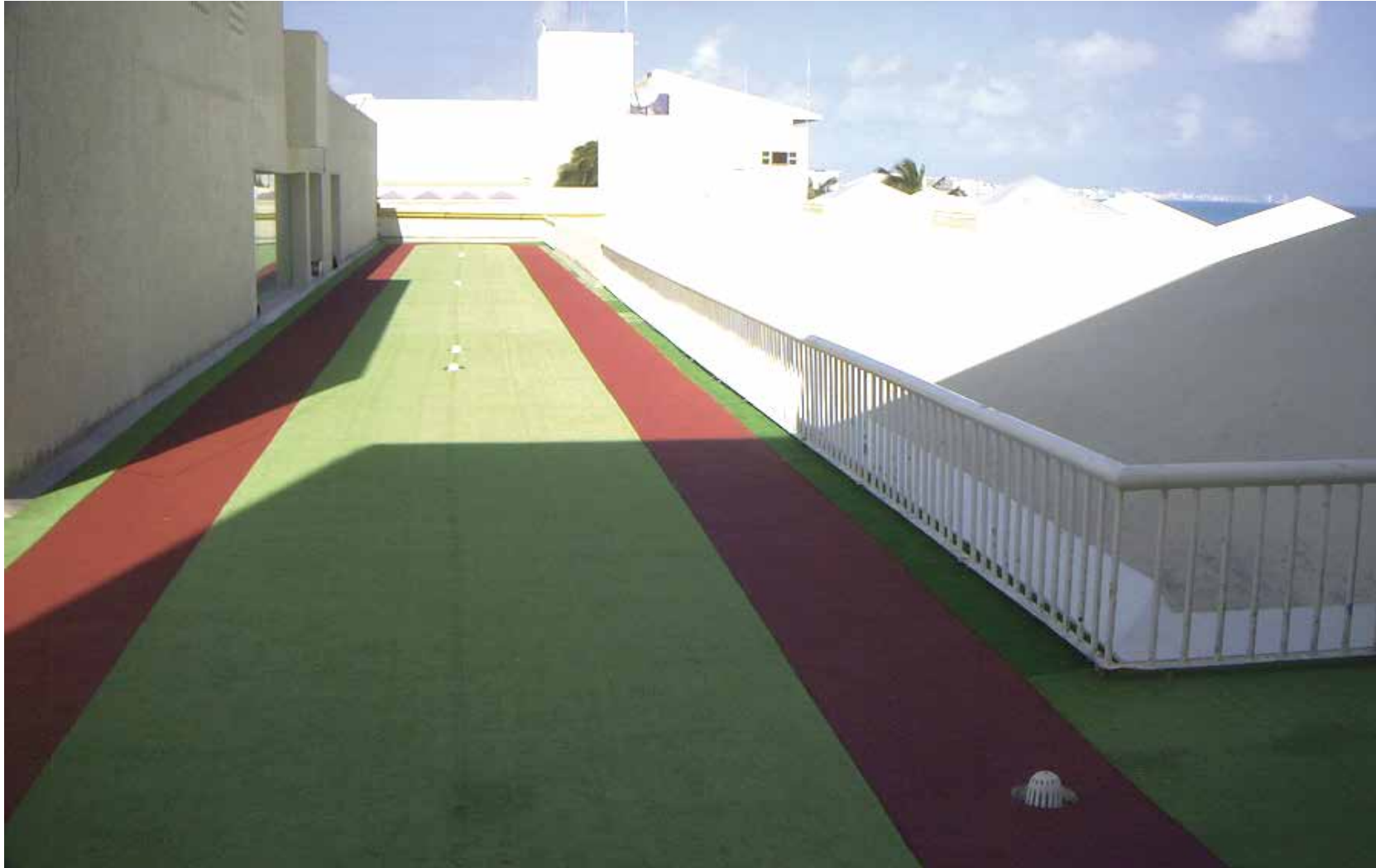
Vista de los trabajos terminados en la pista de calentamiento.
